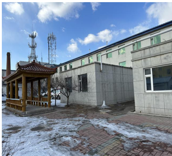
现有污水处理站
