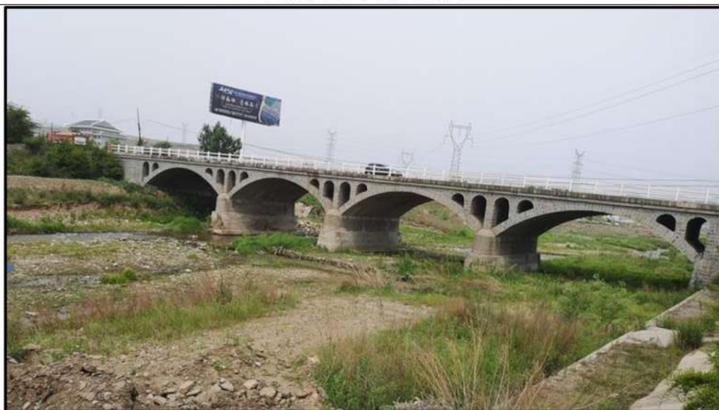
↑ K0+887 龙渊桥现状
